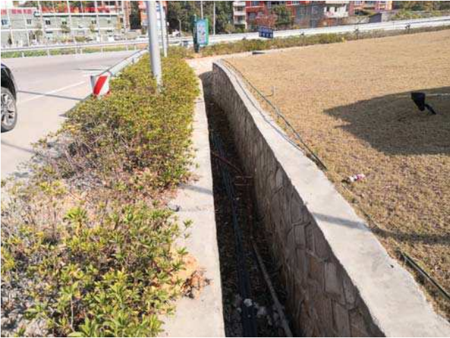
路基排水边沟
