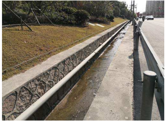
路基排水边沟
