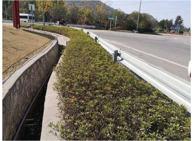
隧道出口处路基两侧绿化
