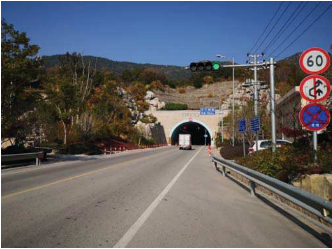
起点处及隧道进口处建成现状
