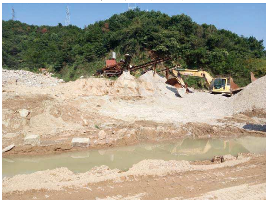
图 3-2 隧道入口处轧石厂及临时堆料
