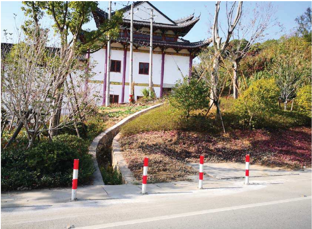
图 1-5 隧道进口端截水沟
