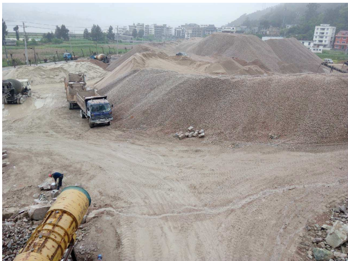
图 1-8 北岸施工临时场地
