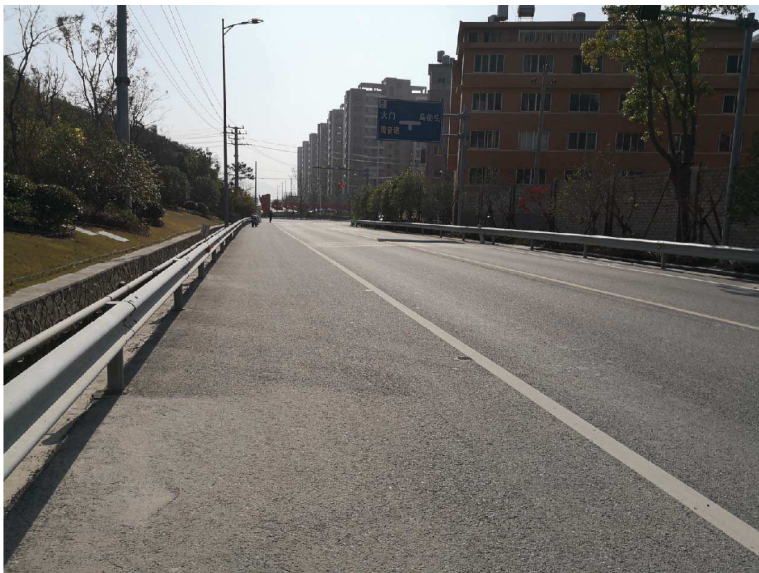
图 1-5 项目起点处路面现状
