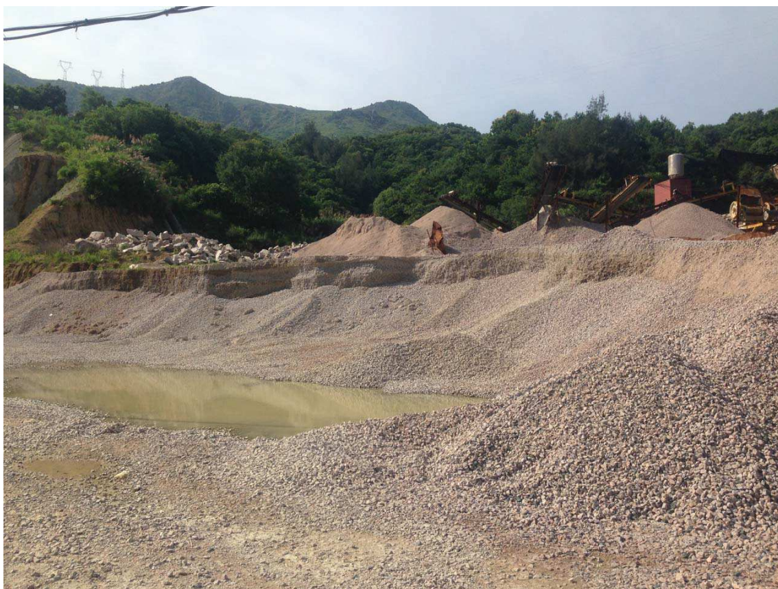
图 1-7 北岸施工临时场地
