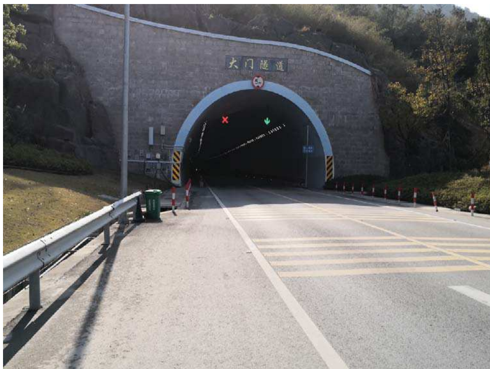
图 1-2 大门隧道出口端
