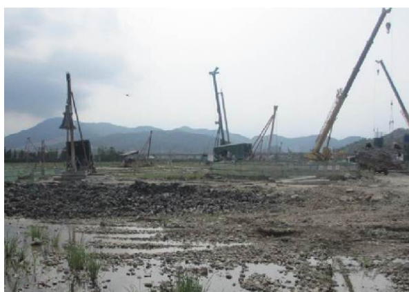
桥梁钻孔灌注施工
