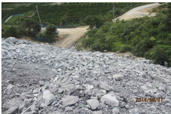
官山隧道出口中转料场（2014 年 8 月）
