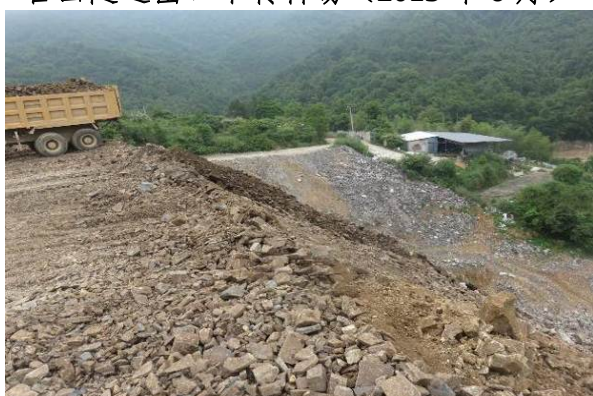
官山隧道出口中转料场（2016 年 7 月）
