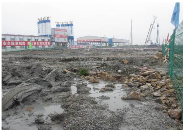
K46+900 处路基填筑（2014 年 2 月）
