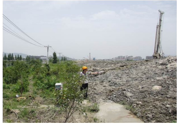
钻渣集中堆放
