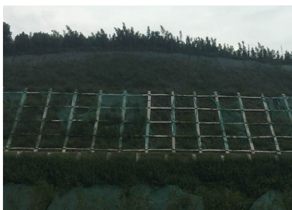
K19+500 处开挖边坡（2019 年 4 月）
