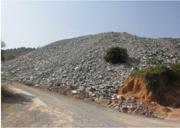
官山隧道出口处中转料场现场影像资料
