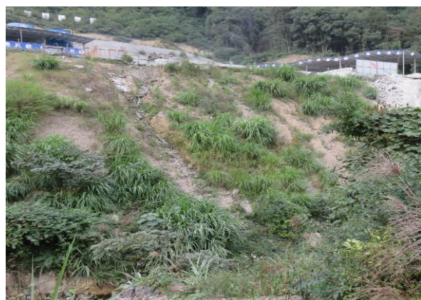
边坡撒播草籽绿化
