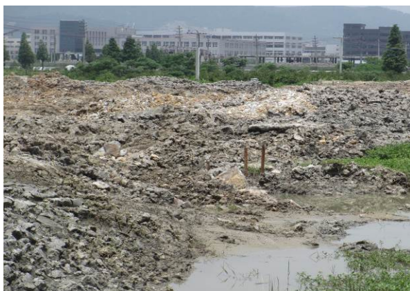
K51+500 处临时堆土场（2014 年 6 月）
