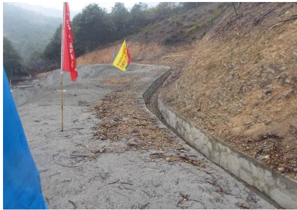
隧道工程区截水沟
