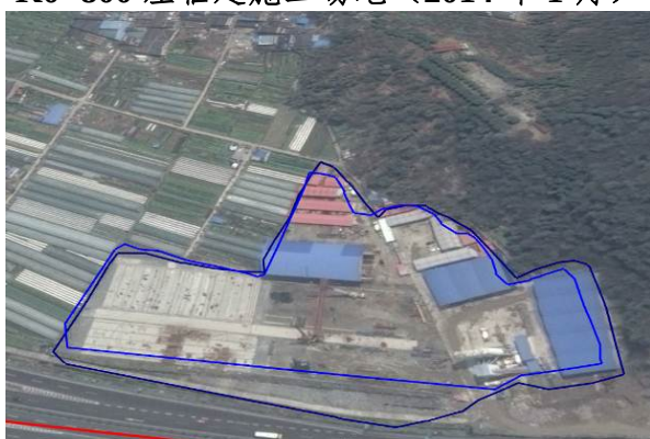
K0+800 左临建施工场地（2017 年 1 月）
