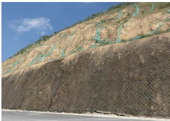
路基边坡密目网苦盖
