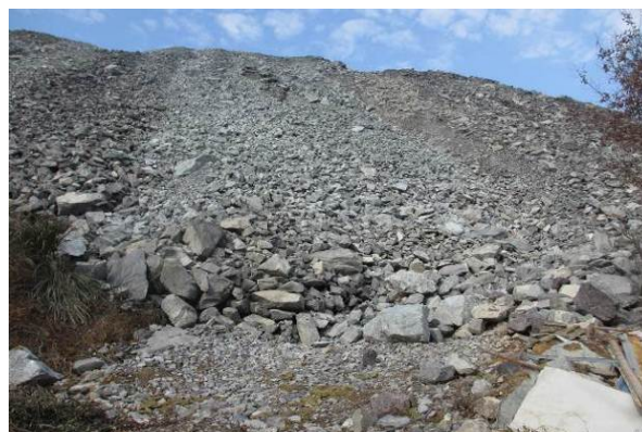
官山隧道出口中转料场（2015 年 1 月）
