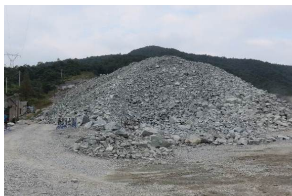
乌岩尖隧道出口中转料场（2015 年 9 月）
