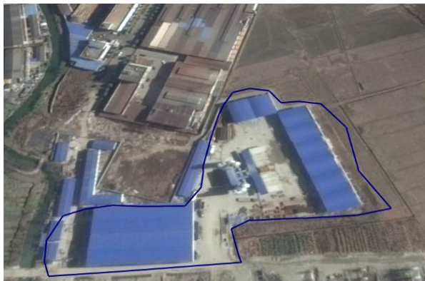
K27+600 临建施工场地 (2015 年 1 月)
