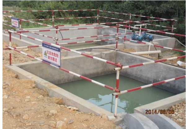
岙岭隧道进口前方沉淀池
