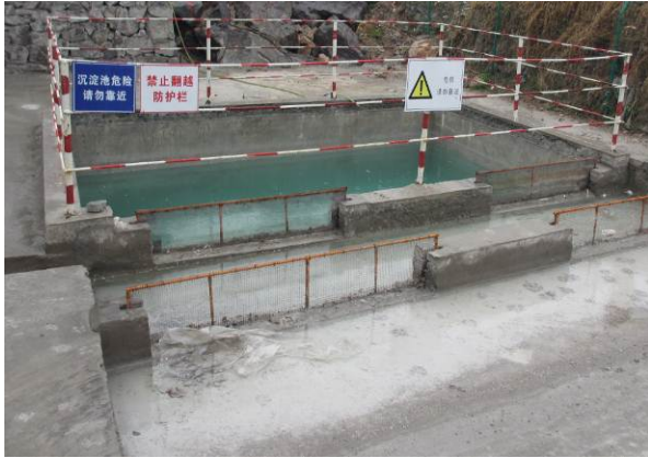
1 标拌合站处沉淀池
