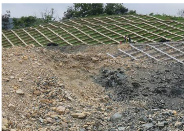
K19+500 处开挖边坡（2015 年 6 月）
