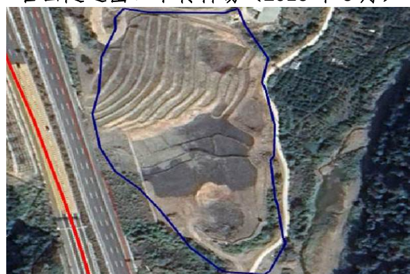
官山隧道出口中转料场（2018 年 9 月）
