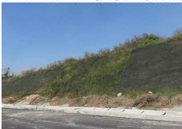
路基边坡撒播草籽
