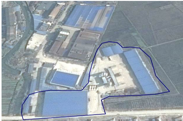
K27+600 临建施工场地 (2017 年 8 月)
