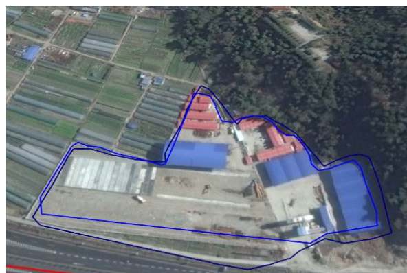
K0+800 左临建施工场地（2015 年 1 月）
