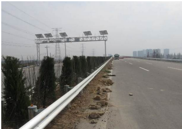
路基工程中央绿化带绿化
