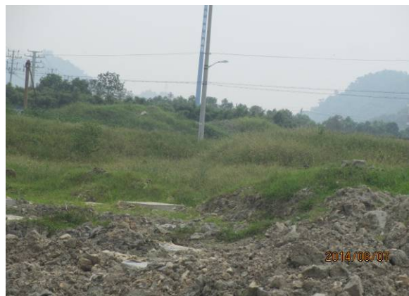
K13+500 处临时堆土场（2015 年 4 月）
