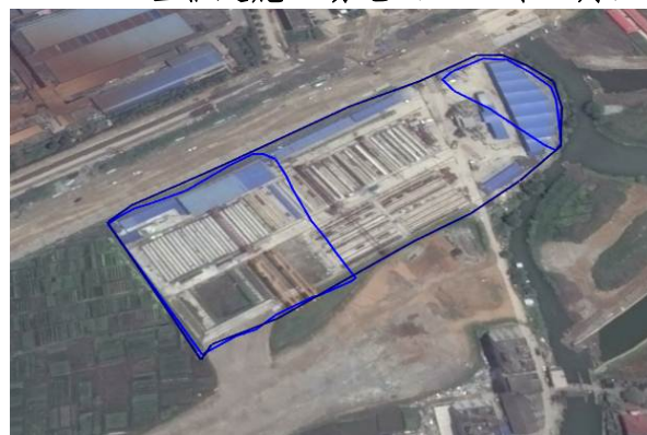
K11+500 临建施工场地（2015 年 6 月）
