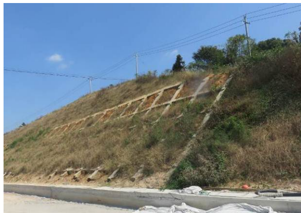
路基边坡网格兰
