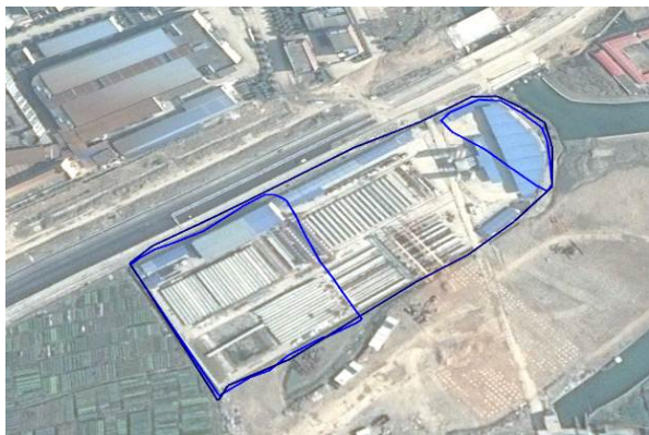
K11+500 临建施工场地 (2017 年 7 月)
