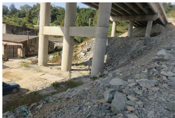
乌岩尖隧道出口中转料场（2017 年 10 月）
