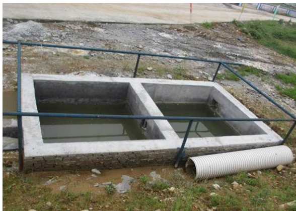
路基区临池沉砂池
