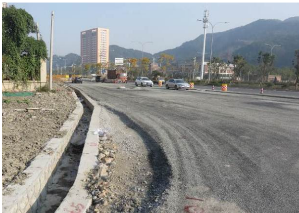
路基工程区排水沟
