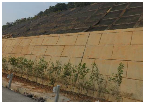
路基工程区栽植灌木
