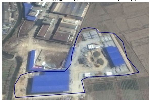
K27+600 临建施工场地 (2014 年 2 月)
