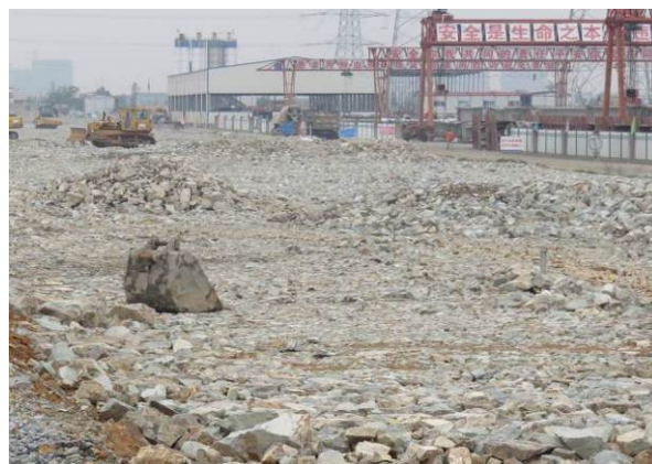
K46+900 处路基填筑（2015 年 4 月）
