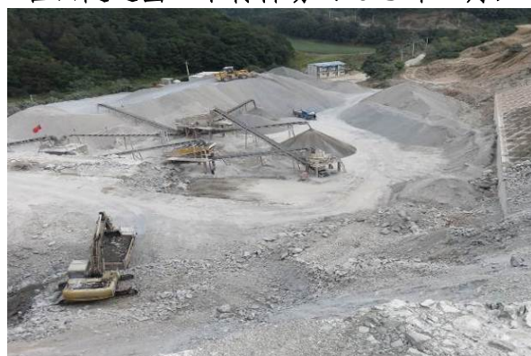
官山隧道出口中转料场（2016 年 6 月）
