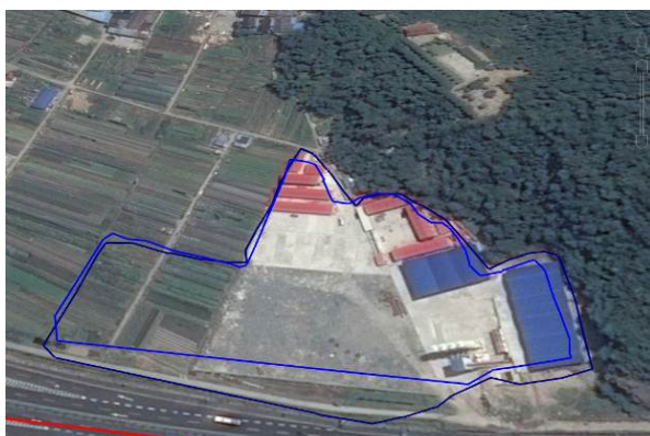
K0+800 左临建施工场地（2014 年 1 月）
