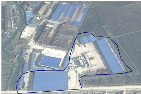
K27+600 临建施工场地 (2014 年 1 月)
