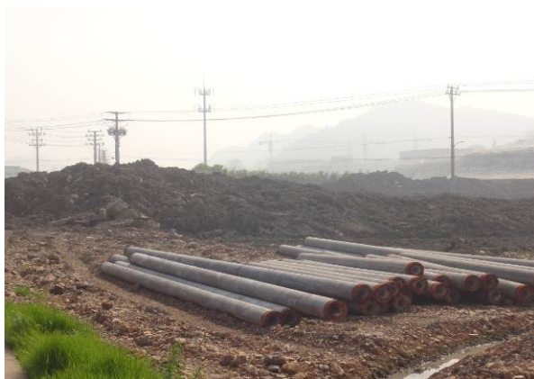
K13+500 处临时堆土场（2014 年 4 月）
