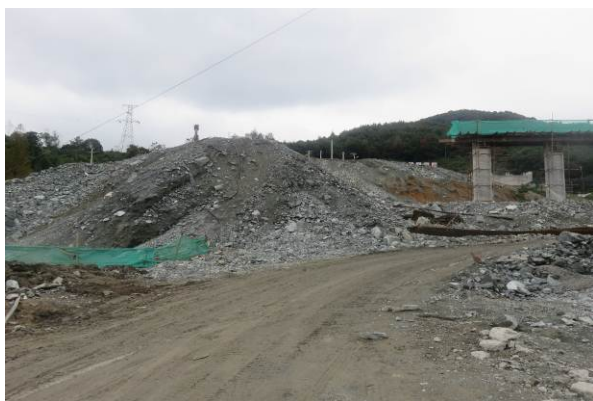
乌岩尖隧道出口中转料场（2016 年 4 月）
