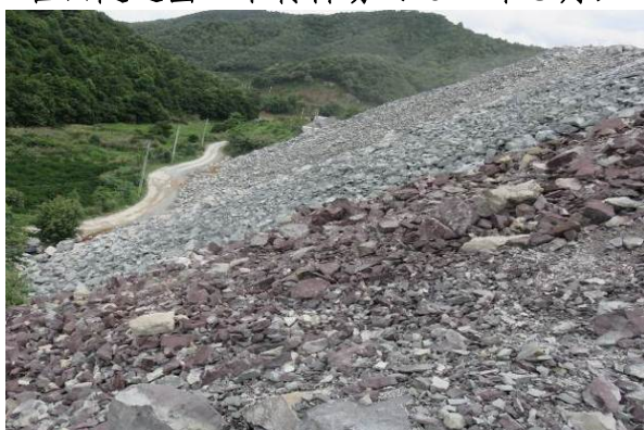
官山隧道出口中转料场（2015 年 6 月）
