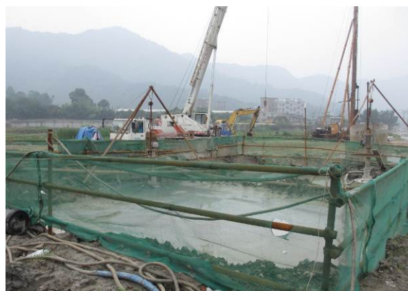
泥浆池已加宽加高
