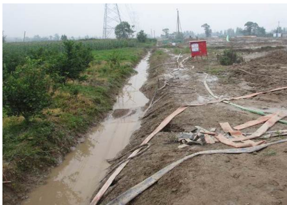
路基区临时排水沟
