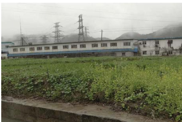
1 标施工营地及施工场地复耕恢复
