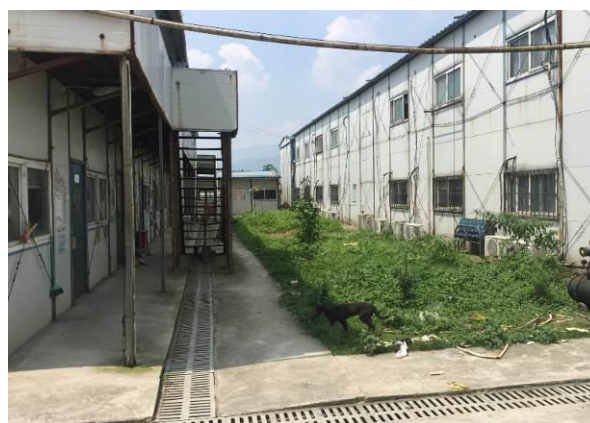
施工场地临时排水
