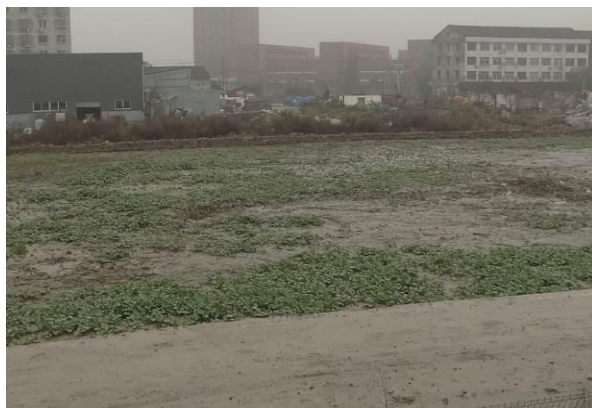
11 标施工营地、预制场及钢筋加工场恢复
