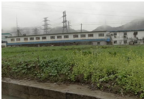
1 标施工营地及施工场地恢复
