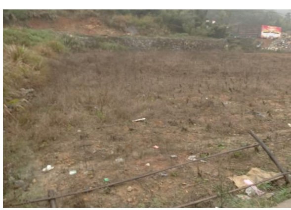
8 标湖岭背出口施工场地恢复
