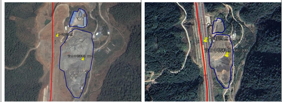
路基、施工场地及官山隧道出口中转料场-2016 年 6 月
