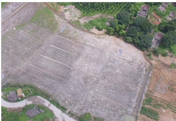
横山隧道出口中转料场恢复
