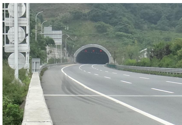
畚箕山隧道出口绿化恢复
