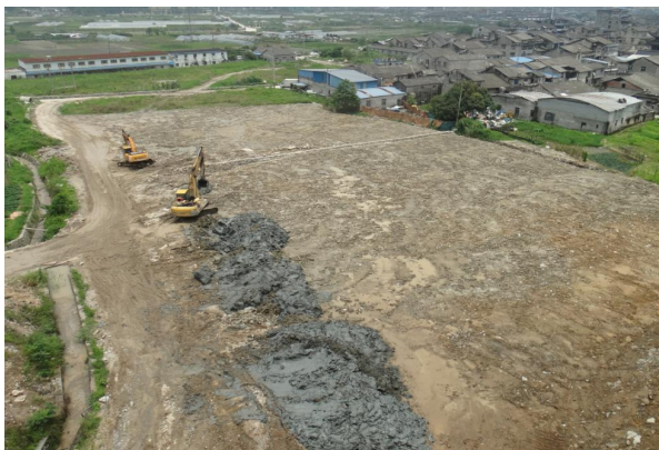
太师岭(石鼓岭)入口中转料场土地恢复
