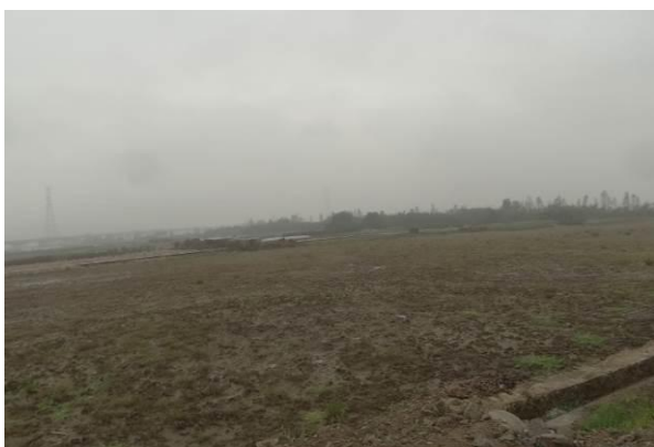
7 标拌合站、预制场及钢筋场恢复
