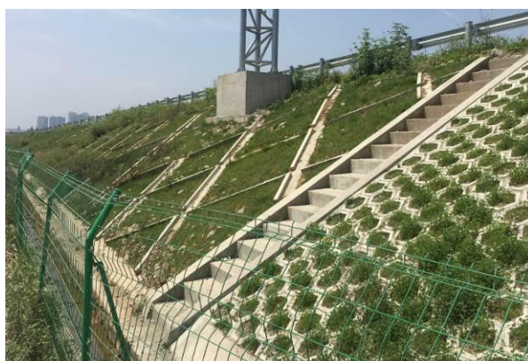
K32+600 路基边坡框格植草护坡
