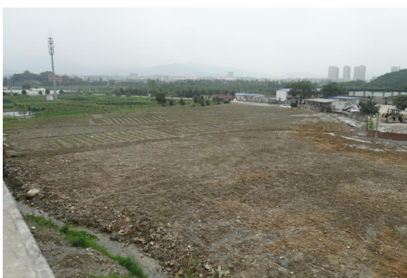
4 标施工营地及拌合站恢复
