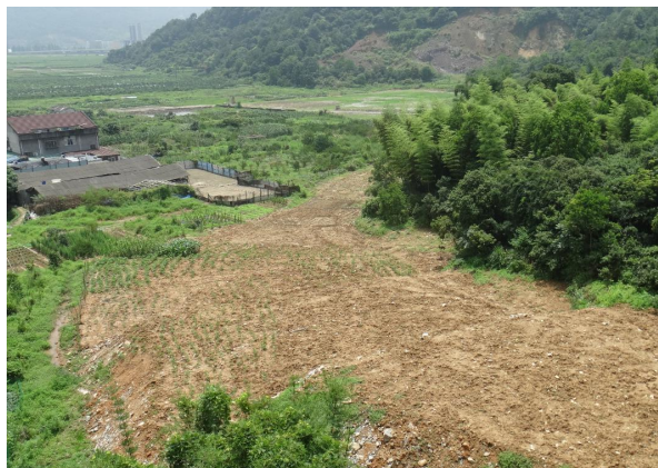
6 标岙岭入口工区拌合站、碎石场恢复
