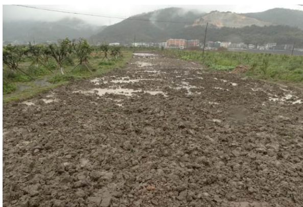
5 标施工营地、拌和站及便道恢复
