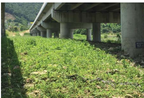
雄溪高架桥下方植被恢复
