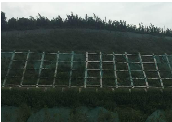
路基边坡苫盖防护
