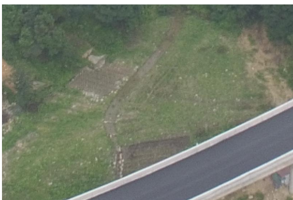
正岙隧道入口中转料场恢复
