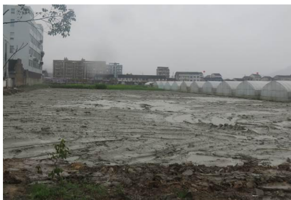
6 标施工营地恢复
