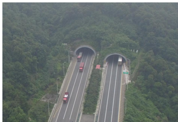
太师岭隧道出口洞脸防护及排水
