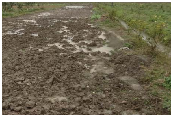
5 标施工便道复耕恢复
