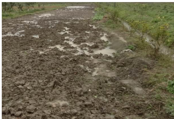
5标施工便道复耕恢复
