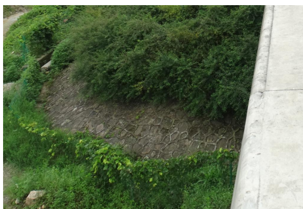
桥台锥坡防护及截排水
