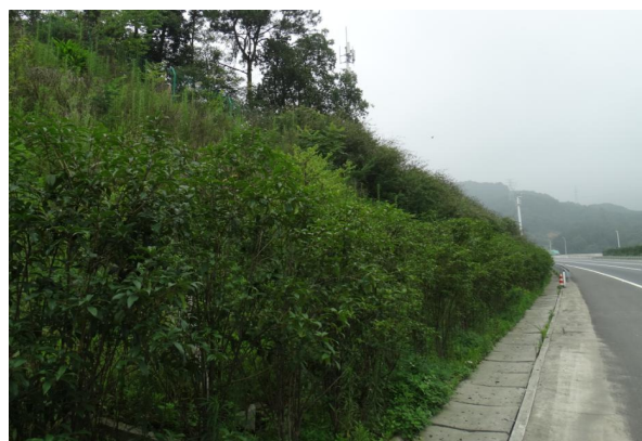
路基排水及绿化防护
