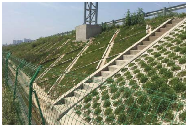
K32+600 路基边坡框格植草护坡
