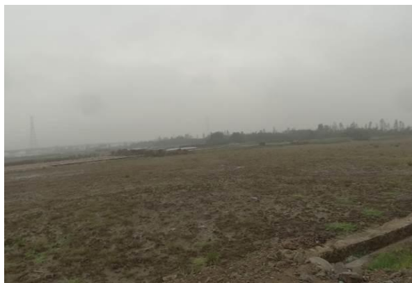
7 标拌合站、预制场及钢筋场恢复
