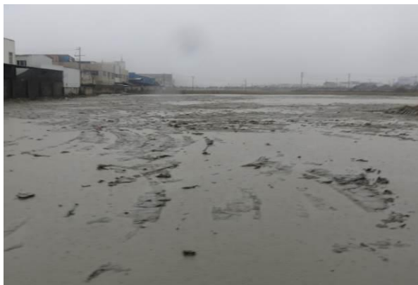
6 标钢筋场及拌合站恢复
