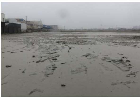
6 标钢筋场及拌合站恢复
