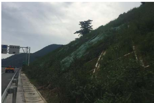
K6+122 路基边坡防护及排水
