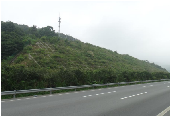
K6+150 路基边坡防护及排水
