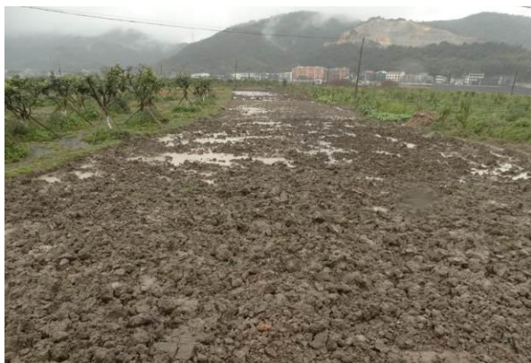
5 标施工营地、拌和站及便道恢复
