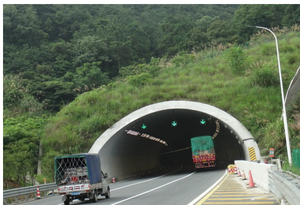
正岙隧道洞脸截排水及绿化恢复
