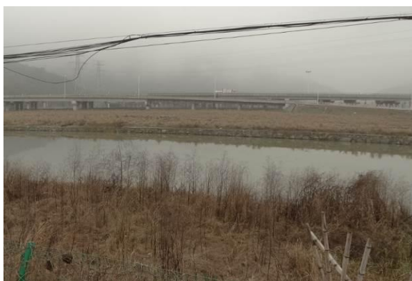
9 标拌合站及预制场恢复
