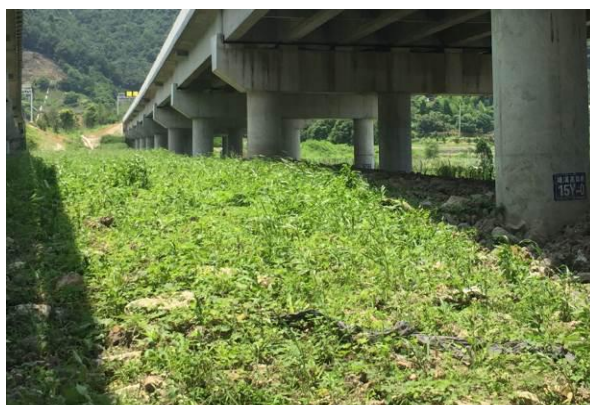
雄溪高架桥下方植被恢复
