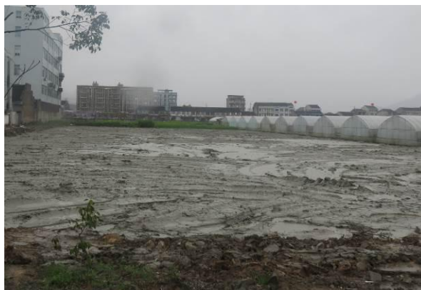
6 标施工营地恢复
