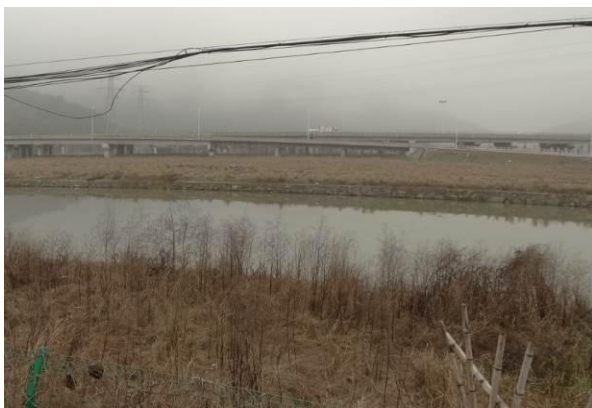
9 标拌合站及预制场恢复
