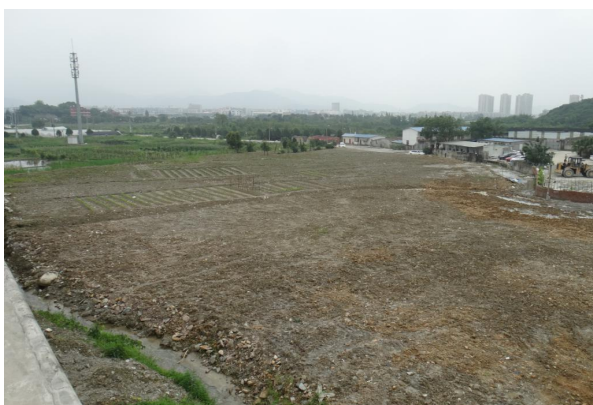
4 标施工营地及拌合站恢复
